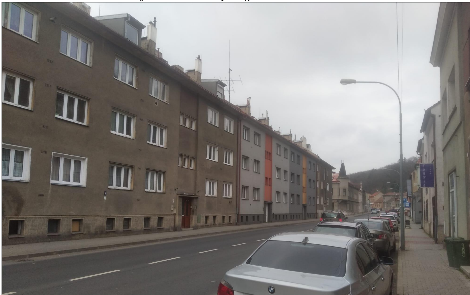
Obr. 16: Fotodokumentace zástavby v okolí kritického místa priority I ve městě Kralupy nad Vltavou - ulice Přemyslova (pohled směrem na východ), komunikace III/10148
