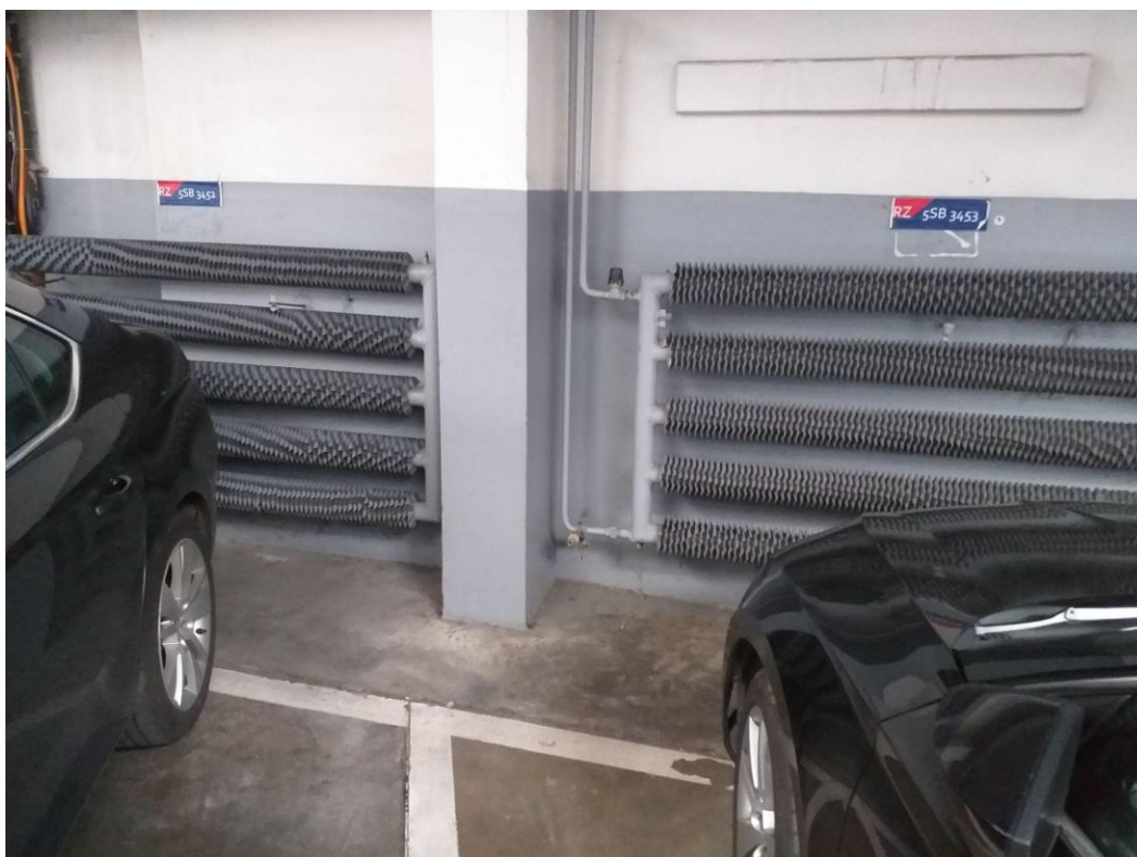
Foto č. 26: Garáž ve vnitrobloku
