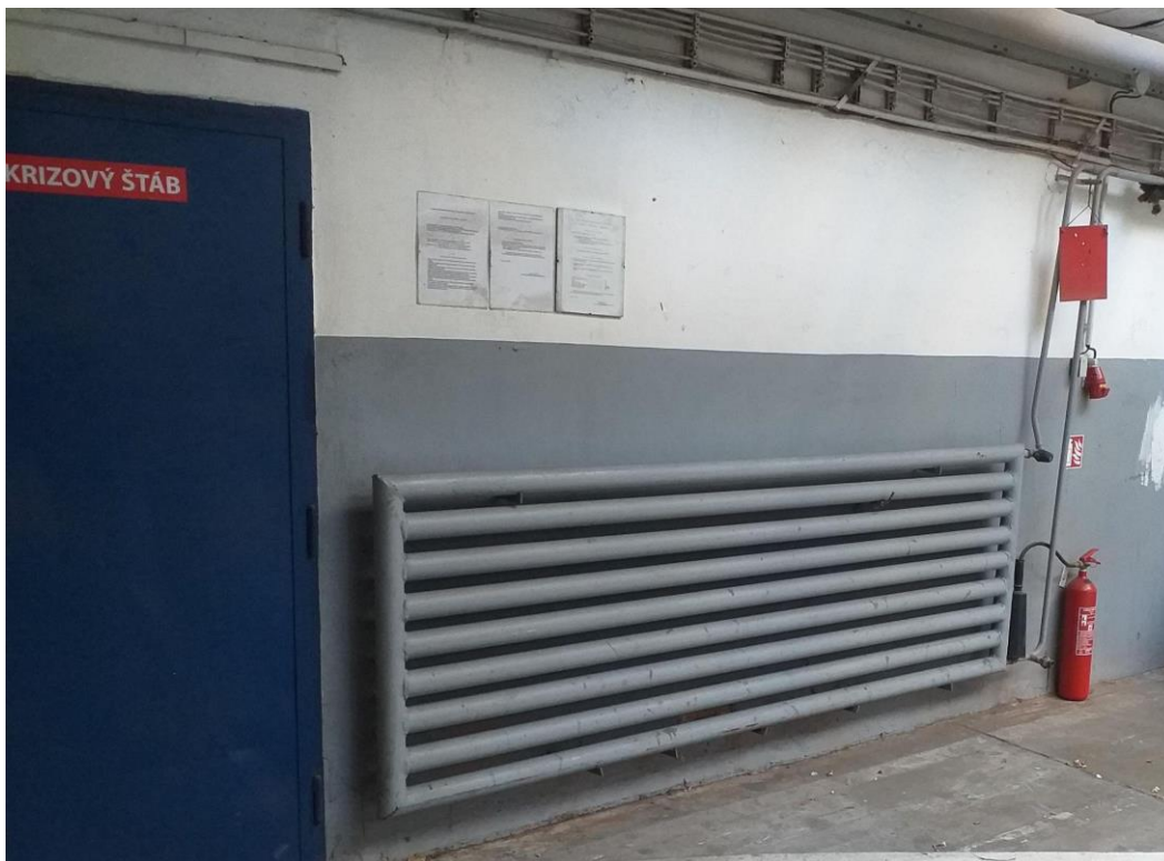
Foto č. 25: Garáž ve vnitrobloku
