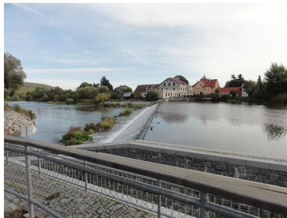
Obr. 5.2 – jez Černošice s malou vodní elektrárnou, rybím přechodem a propustí pro vodáky
