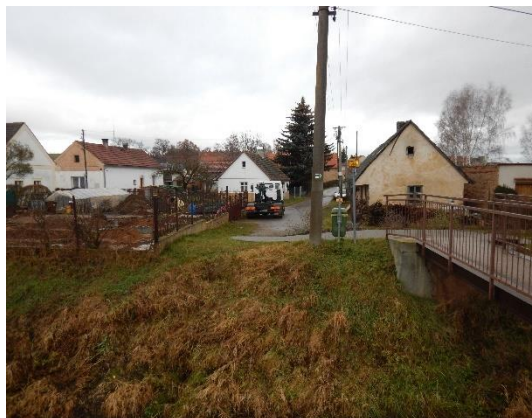
Obrázek 32 lávka a místo, kde dochází k přetoku Q_{20} do zástavby na LB v Senomatech, ř. km 26,31
