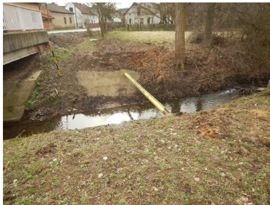
Obrázek 26 silniční most v Oráčově a zaplavované území na PB, ř. km 35,00
