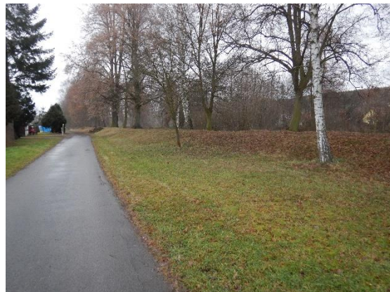
Obrázek 43 protipovodňová hrázka v ulici Draha v Senomatech, ř. km 25,8 – území za hrázkou je při Q_{100} kompletně zatopeno
