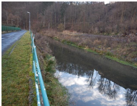
Obrázek 3 upravené a napříměné koryto Rakovnického potoka v Křivoklátu
