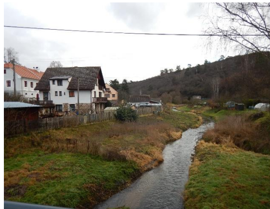
Obrázek 6 složené lichoběžníkové koryto v Pustovětech
