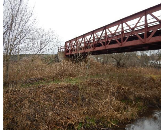
Obrázek 21 žel. most, kde dochází k nátoku přes LB do areálu betonárky
