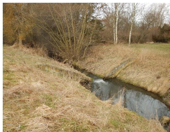
Obrázek 12 typický spádový stupeň na Rakovnickém potoce (příklad z obce Švihov, ř. km 33,5)
