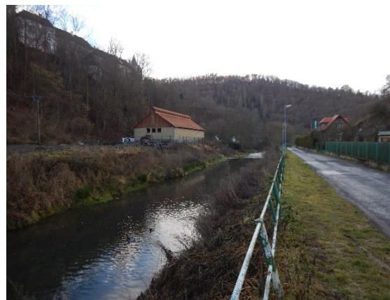
Obrázek 53 ulice v Křivoklátu je na PB kompletně zaplavena vč. navazujících pozemků, na LB břehu budova ČOV Rakovník, ř. km 2,1
