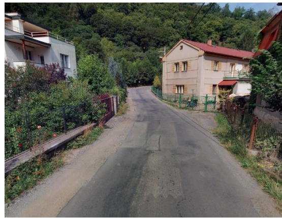
Obrázek 55 silnice II/227 v Křivoklátu je při Q_{100} zaplavena, ř. km 1,70
