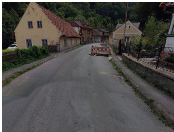
Obrázek 56 silnice II/201 a okolní domy, při Q_{100} kompletně zaplaveny, ř. km 1,10
