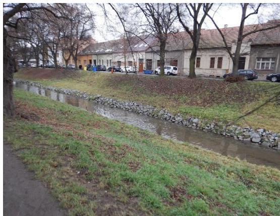
Obrázek 9 upravené koryto s opevněním ve městě Rakovník
