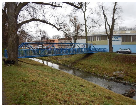
Obrázek 49 lávka u zimního stadiónu, voda zde natéká do PB, ř. km 19,70
