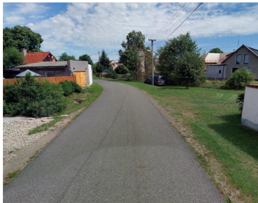
Obrázek 30 ulice V Chaloupkách v Senomatech, kde dochází k přetoku Q_{20} do zástavby, ř. km 26,52
