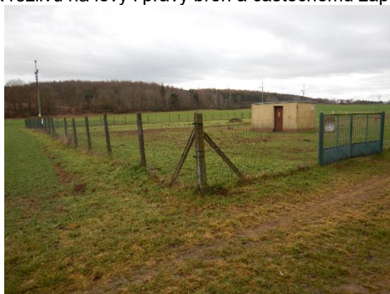
Obrázek 34 ochranné pásmo jímacího zařízení pro pitnou vodu zaplavené při Q_{20} , ř. km 23,4
