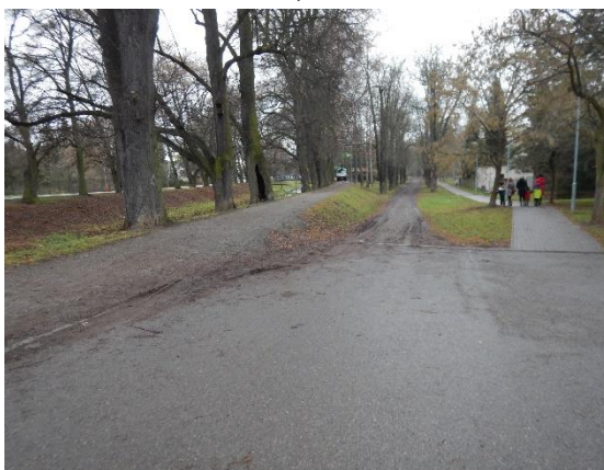
Obrázek 48 konec hrázky podél Čermákových sadů, voda se z LB vrací do koryta a přetéká na PB, ř. km 19,78
