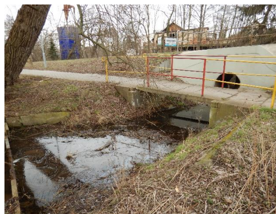
Obrázek 18 příklad nevhovujícího objektu vodních nádrží (nekapacitní průtočný profil na odtoku od bezpečnostního přelivu, Velký rybník)
