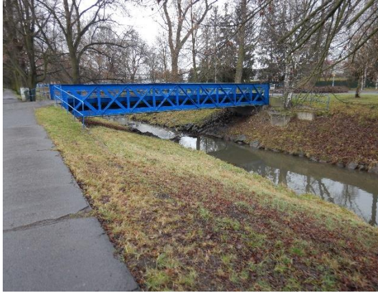
Obrázek 44 most v ulici Vackova, kde dochází k rozlivu Q_{100} na levý břeh, ř. km 21,63
